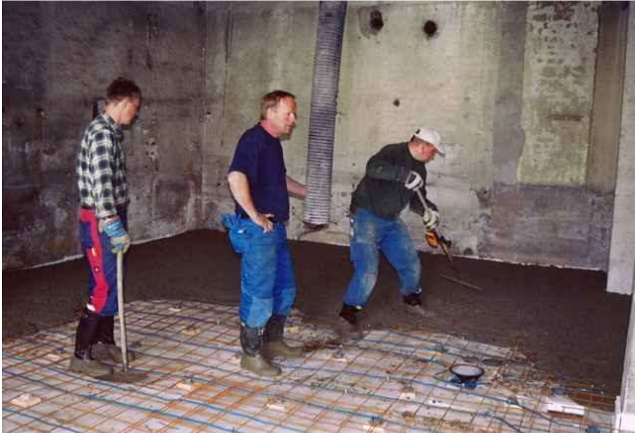
Støping av gulv i oppholdsrommet, fra venstre Tor Flom, Halvor Jensen og Odd Inge Lunden.
